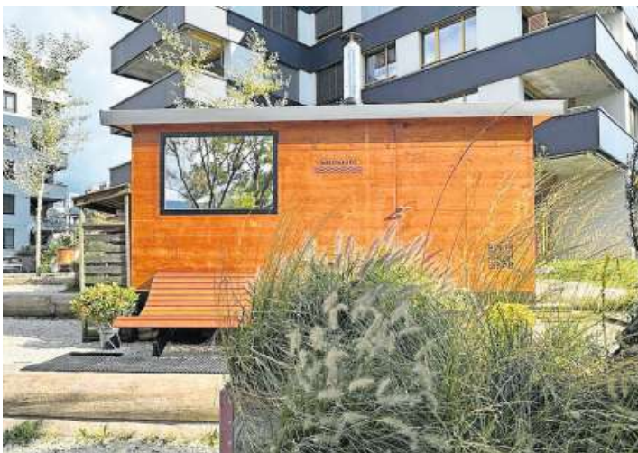
Der Rauch störte die Anwohnerinnen und Anwohner, deshalb wurde der Wagen auf einen Elektroofen umgerüstet. Bild: zvg
